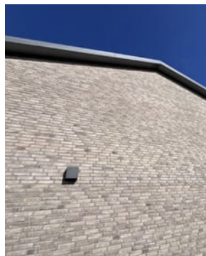
Den gamla träfasaden har ersatts av naturfärgat tegel.
